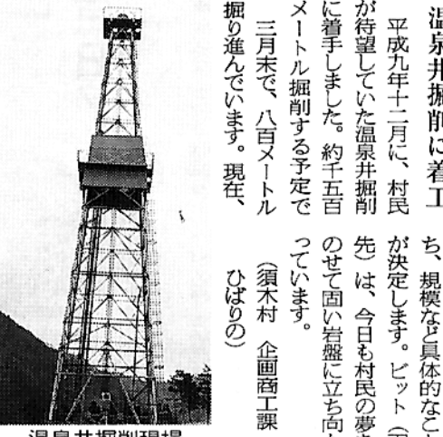
温泉井掘削現場
